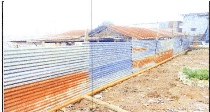
Foto 4: sustrucción de muro de lamina por muro de block
